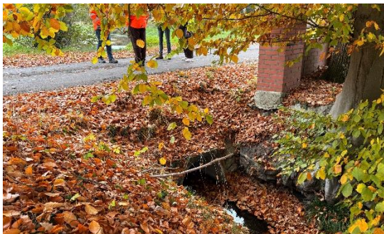
3: Streckenabschnitt 2 – Durchlass - Osten
