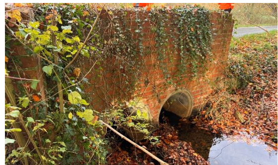
4: Streckenabschnitt 1 – Durchlass - Osten
